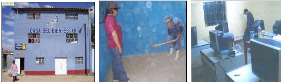
Casa del Bien Estar en Ayacucho Obras de acondicionamiento aula de informática
